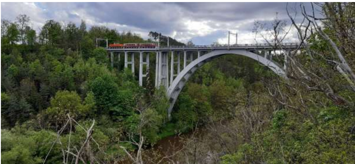
Obrázek 17 - most „Bechyňská duha“, ikonická stavba tratě Tábor – Bechyně slouží již od roku 1928
