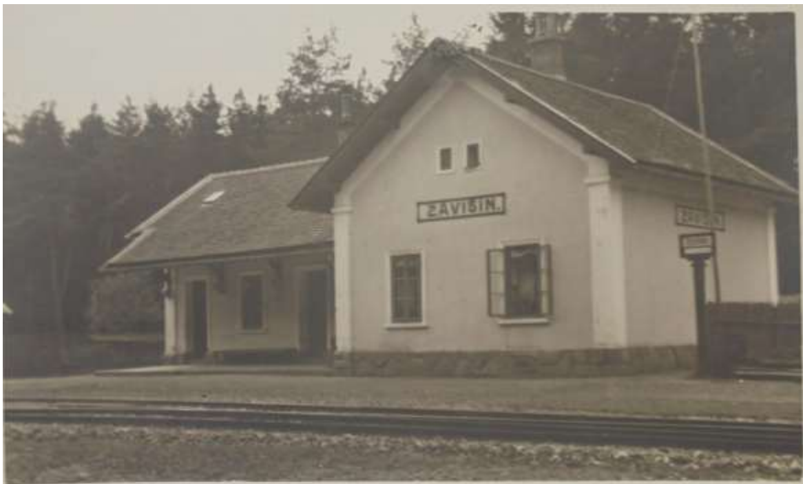
Obrázek 18 – historická fotografie ŽST Závišín na trati č. 203 Strakonice – Březnice
