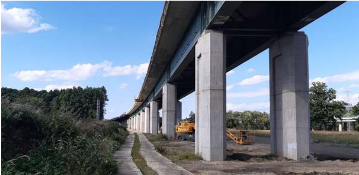
Obrázek 3 - výstavba IV. Železničního koridoru, stavba Doubí – Soběslav, nedaleko obce Zvěrotice
