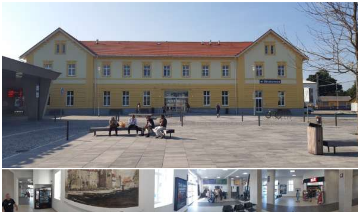
Obrázek 67 – přestupní terminál ve Strakonících, který umožňuje komfortní přestup autobus – vlak. Celé území prošlo zásadní proměnou v letech 2020 – 2021 výstavbou přestupního terminálu u ŽST Strakonice, vybudování P+R, K+R a B+R a rekonstrukcí výpravní budovy, která poskytuje dostatek pohodlí při čekání. V sousedství se rovněž nachází středně velký obchod s potravinami
