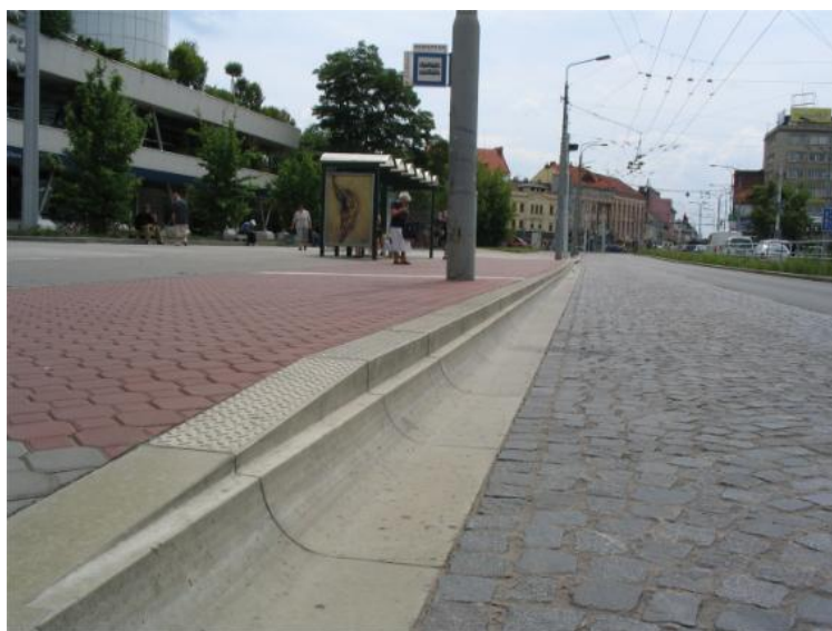
Obrázek 1 – ukázka kasselského obrubníku, zdroj: mhd.zastavka.net
